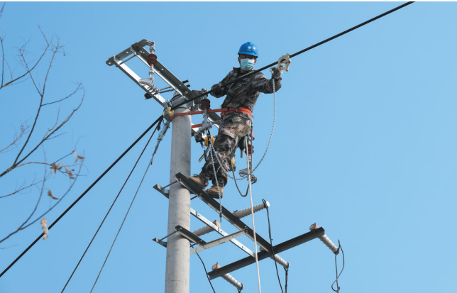
11月19日凌晨,在霸州市南孟镇中岸村,霸州供电公司工作人员为10千伏211三江线四岸支线更换导线,彻底解决该台区的低电压问题,提高了线路安全运行水平,进一步增强线路供电能力和配网抵御恶劣天气能力,保障客户安全稳定用电。 赵亚彬 许文军 摄
