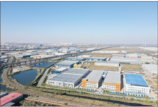
临津产业园规划面积10.73平方公里,建设用地7.4平方公里,是唐山市汉沽管理区嵌入天津滨海新区之中的一块“飞地”,享受滨海新区的资源、服务和生产条件。目前,投产或部分投产企业104家,在建企业10家,是津冀(汉沽)协同发展示范区的主战场。图为临津产业园鸟瞰图。裴春晶 摄
