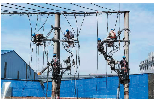
10月28日,文安供电公司完成223夏村线切负荷和新架22公里线路改造,极大缓解兴隆宫工业园区及周边区域即将到来的冬季负荷高峰,确保电力线路安全稳定运行。 徐闻天 摄
