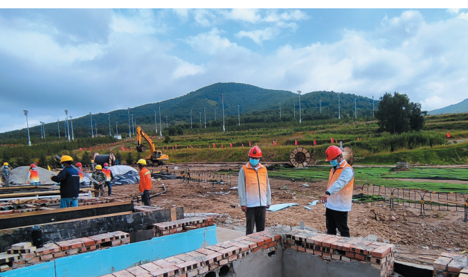
国网冀北工程管理有限公司驻队监护在冬奥临电工程现场使用智能安全帽开展监护工作。
