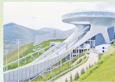
国家跳台滑雪中心:外形酷似中国传统饰物“如意”,故又称“雪如意”,将承担跳台滑雪、北欧两项两个分项的比赛(其中北欧两项与国家越野滑雪中心共同承担),共将产生8枚金牌。“雪如意”是世界上首个采用全钢筋混凝土超长框架结构、首个在顶部出发区设置大型悬挑建筑物的跳台滑雪场馆,是世界上最具设计感的跳台滑雪场馆,还有世界上最长的跳台滑雪赛道。
