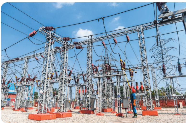
四季度以来,开滦范各庄矿业公司着眼保障供电系统安全可靠运行,采取加强走动巡查、强化设备检修、规范倒闸操作、开展隐患排查等措施,不断强化管理,提高供电系统运行安全可靠度。图为该公司机电科员工正在按照标准进行验电操作。
