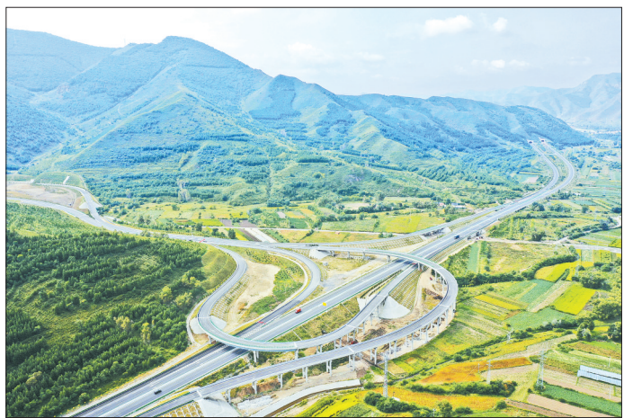
这是8月31日拍摄的延崇高速河北段延伸工程张家口崇礼白旗互通枢纽(无人机照片)。当日,延(庆)崇(礼)高速公路河北段延伸工程顺利通车。延崇高速河北段是北京2022年冬奥会期间进入张家口崇礼赛区的公路主通道,延伸工程属于延崇高速二期配套工程。延伸工程连通延崇高速与首都环线,实现了京礼高速公路全线与河北路网的无缝衔接。
