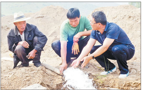
在尚义县红土梁镇五十家行政村,驻村干部王录(右一)与村干部、水务局技术人员在一起修复自来水管道。今年以来,尚义县共选派94个驻村工作队,紧紧围绕党传党的政策、建强村党组织、推进强村富民、提升治理水平、为民办事服务等工作重点,与村“两委”密切协作,全力做好脱贫攻坚与乡村振兴的有效衔接。
