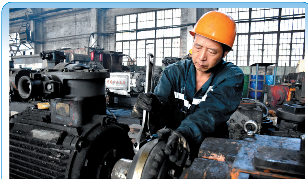
7月18日，邯矿集团郭二庄矿职工正在检修水泵。进入主汛期，该矿强化排水设施检查维护，保障排水能力达到要求，提高矿井防灾抗灾能力，确保安全度汛。程矿生 鲁谊民 摄
