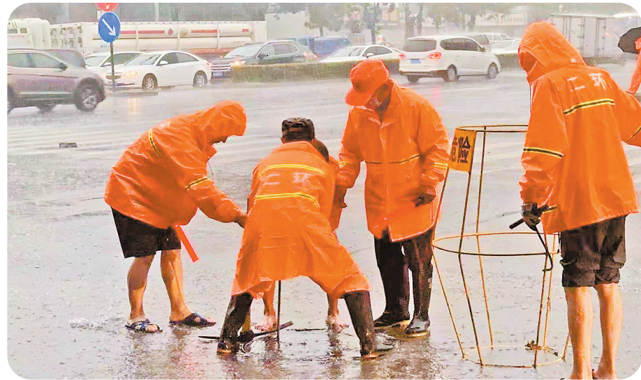
环卫工人暴雨之下人工疏通下水道泄水口,以便快速排水。
