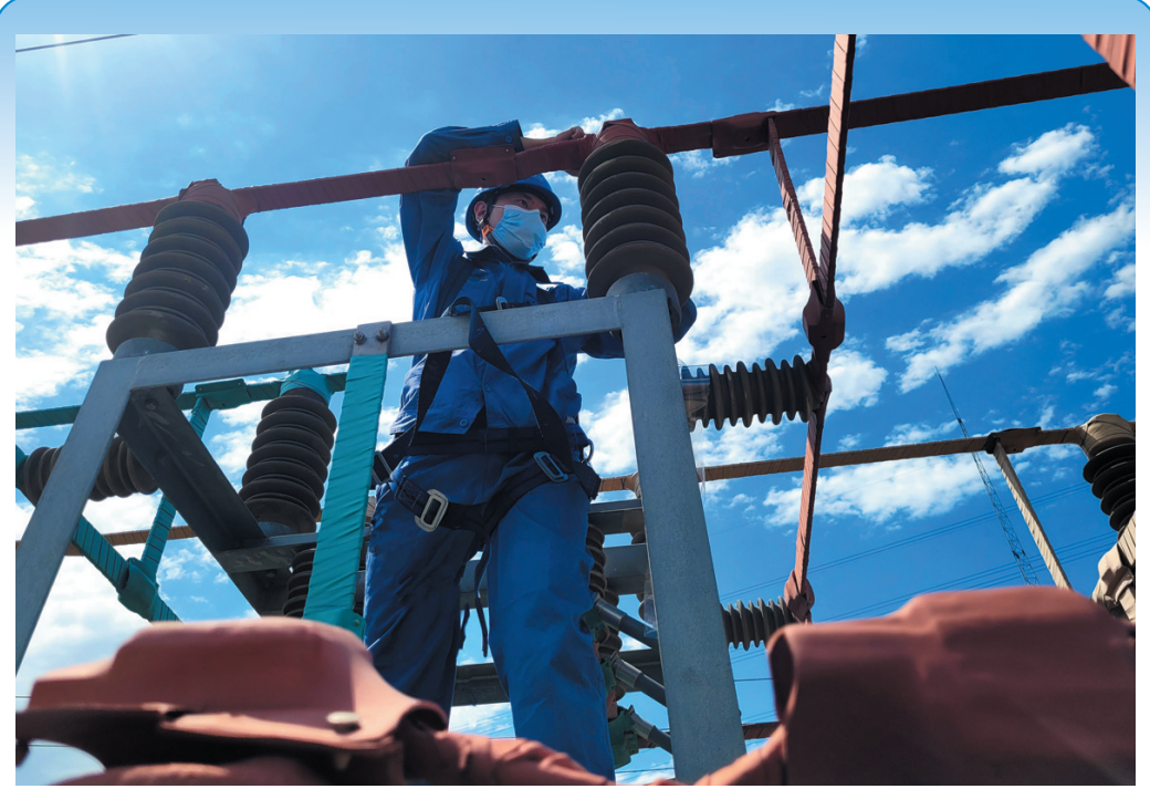
近日，河北省各地气温持续攀升，电网负荷持续高位运行。7月10日21时29分，河北南部电网最大负荷达到4198.2万千瓦，刷新去年冬季以来日负荷纪录，负荷创历史新高。目前电网运行平稳，电力供应充足。图为国网保定供电公司员工在220千伏棋盘站开展消缺工作。 马千里 摄
