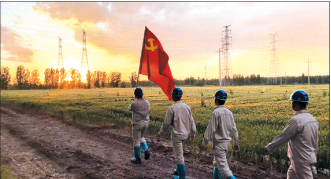
5月26日,文安县供电公司党员先锋队开展雨后线路特巡,保障辖区供电设备安全可靠。同时,对容易发生汛情的输电线路杆塔进行检查,确保电网安全度汛。 胡晓东 摄
