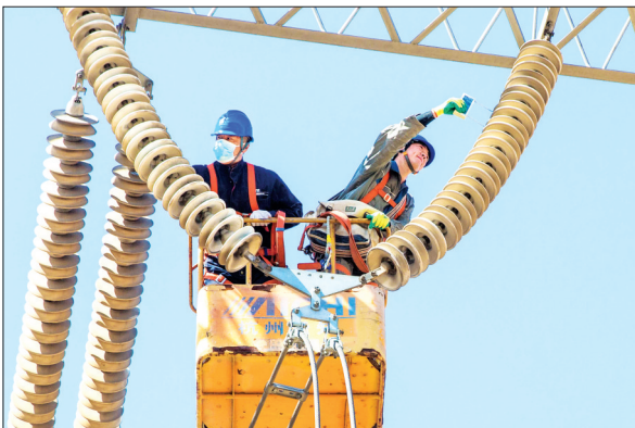
3月22日,秦皇岛供电公司员工对220千伏戴河变电站供电设施进行春季检修和预防性试验。该公司今年春检预试计划安排8座变电站,63条110千伏以上线路预试和103项停电检修工作,检修设备2000余套。
