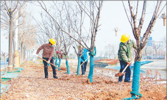
日前,衡水市实施的主城区水系生态修复工程已进入收尾阶段,其中连接班曹店排干和滏阳河的迎宾河段为城市景观河道,项目建设单位正在对景观绿化部分进行提升改造,力争早日完成衡水的“民心河”工程。图为施工人员对迎宾河进行植被绿化。 陈月振 宋兵慧 摄
