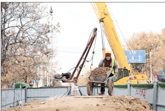
今年以来,枣强县住建局针对县城易积水区域,合理安排管道经度、收水口数量等设施,确保道路雨水管道连接畅通,有效提升雨水管道排涝能力。目前,已铺设雨水管道20多公里。图为雨水管道施工现场。 杨双池 王乐 摄
