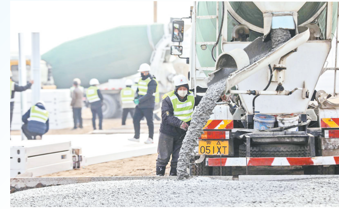
工人们二十四小时不间断施工,争分夺秒搭建集成房屋。
