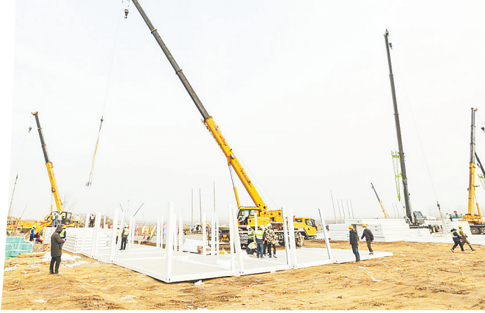
集成房屋正在紧张搭建,其中每个使用面积为十八平方米,有集成卫浴设施,可实现一房一卫一浴。集成房屋将作为石家庄市抗疫隔离用房使用。
