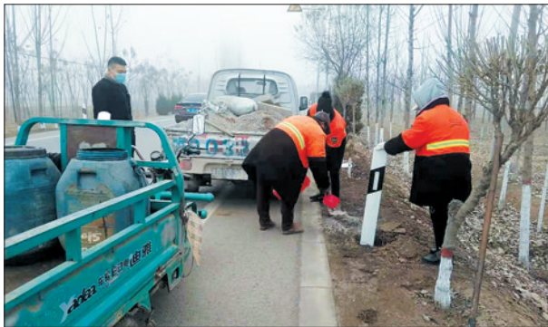
近期，临漳县交通运输局地方道路管理站对管养线路全面开展警示桩、里程碑和轮廓桩等安防设施设置完善工作，为创建安全畅通的农村公路通行环境奠定了坚实基础。 王飞 摄
