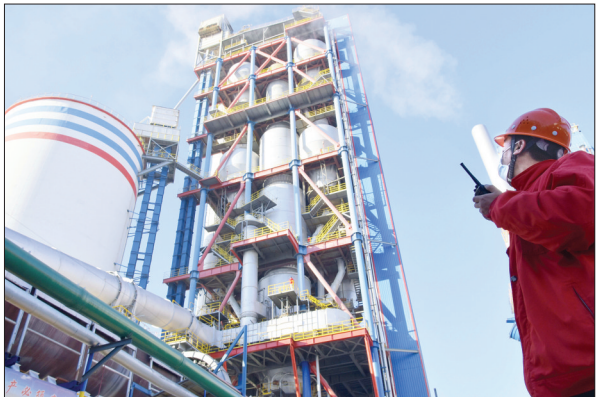
近年来,丰润区沙流河村坚持把发展村集体企业作为带动农民增收致富的有力抓手,不断巩固壮大村集体经济。目前,该村已发展村办企业10余家,年创利税1.5亿元,吸收350多名村民家门口就业增收。图为在丰润区沙流河村一家村办建材企业内工人在巡检设备。
