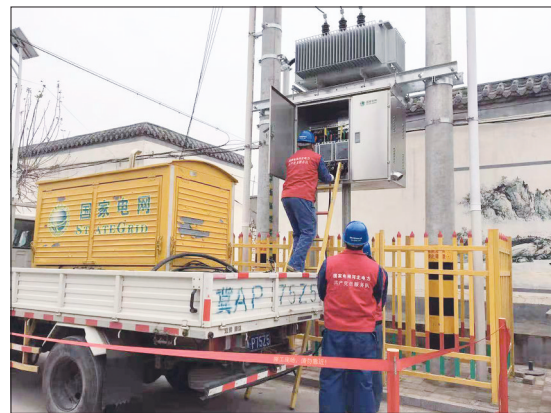
近日,气温骤降。为确保电网安全稳定运行,国网辛集市供电公司开展了电网迎峰度冬反事故演练活动,全力保障辛集市“煤改电”用户温暖过冬。图为该公司员工正在进行反事故演练。 路冲 摄
