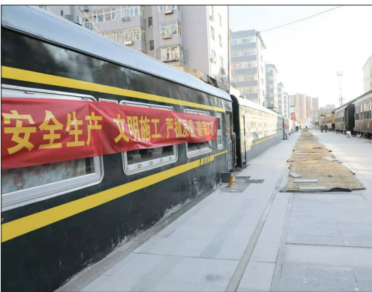
以京张铁路文化为依托的老火车步行街位于桥东区南口路段,采取狭长带状设计,建成后将有140多家档口和餐饮门店入驻,成为一处独具特色的城市休闲餐饮场所。图为建设中的步行街。
