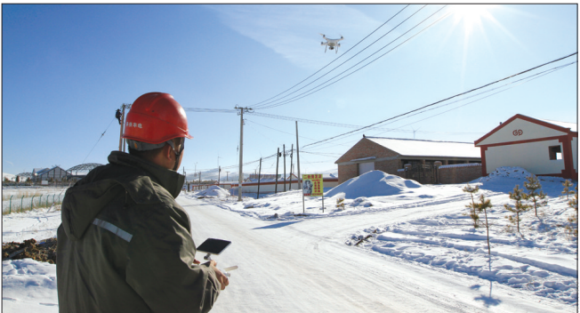
11月30日,丰宁供电公司输电运检班巡视人员协同精品台区验收人员,通过无人机巡检的方式对大滩镇北梁新村精品台区建设进行检查验收,消除高空验收盲区,高质、高效完成精品台区新建工程验收。 马铮 摄
