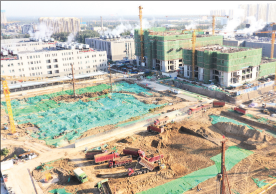
廊坊开发区润泽科技发展有限公司建设项目——润泽国际信息港未来投入运营机房面积达22.5万平方米,能够提供3万架机柜服务能力,可为京津冀信息产业转型提供支撑。图为该项目施工现场。
