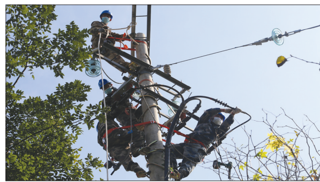
10月13日,冀北廊坊霸州供电公司员工对10千伏231许洋线北头支线15号杆至37号杆导线合金具进行更换,全面提升该线路供电能力。 赵亚彬 摄
