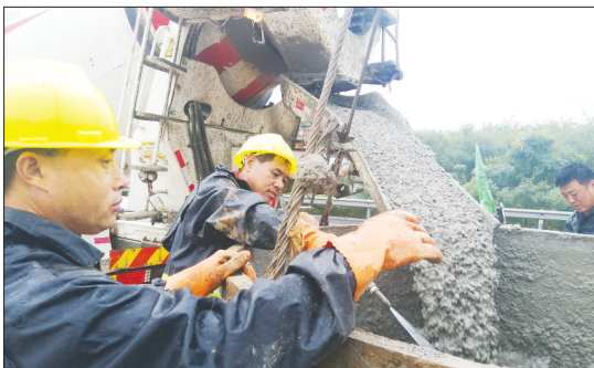
近日,在雄安新区建材通道容易(容城—易县)线RYSG1标段分离式立交桥施工现场,工作人员正在紧张忙碌,抢抓进度。该项目已完成京昆高速中分带内管线迁改,现已完成跨高速桩基基础施工。
