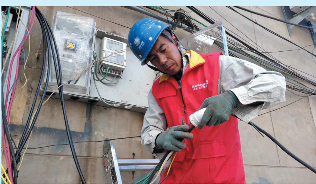
自创建全国文明城市活动开展以来,文安县供电公司主动作为、迅速行动,对县城内影响市容市貌的80个小区废旧电表箱进行更换,对年久老化、不规则线路进行重新布线,合理分配负荷,提升电压质量,为文明城市建设添砖加瓦。 孙立娟 张伟 摄
