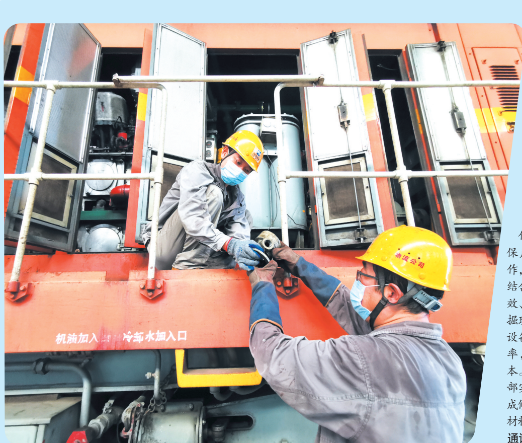
8月10日,河钢唐钢物流分公司机修作业区党员职工正在对内燃机车机械室电器进行维保。该公司党委认真贯彻落实集团重点工作推进会精神,围绕运输保产、降本增效等中心工作,积极组织各基层党支部结合岗位实际开展“降本增效、党员当先”主题活动,挖掘班组长党员技术资源,改进设备检修工艺,提高物流效率,最大限度降低物流成本。7月份,机修车间党支部实现检修收入51万元,完成修旧利旧12.6万元,机车材料消费得到有效控制。通讯员 刘会军 刘立强 摄
