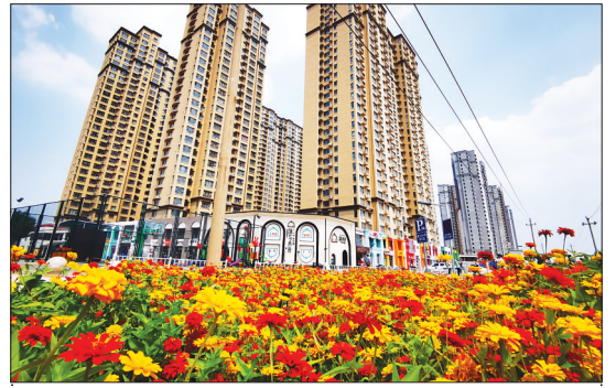
衡水市坚持依法依规、铁腕治理,强力推进市区违建拆除工作,还原城市空间。今年以来共拆除违法建设118处、5.1万平方米。图为桃城区站北路南侧经过整治修建的小花园。张梅胜 卢婉凤 摄
