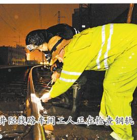
井陘线路车间工人正在检查钢轨接头。
