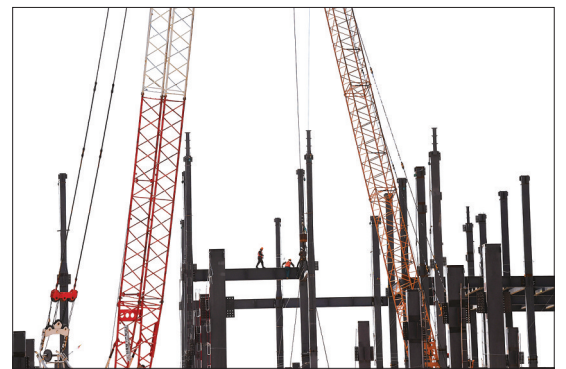
截至目前,怀来县复工复产企业已达411家,复工率100%。该县今年建设重点项目84个,其中省级重点项目6个。图为该县腾讯瑞北云数据中心正在紧张施工。 苏晓瑞 孙慧军 摄
