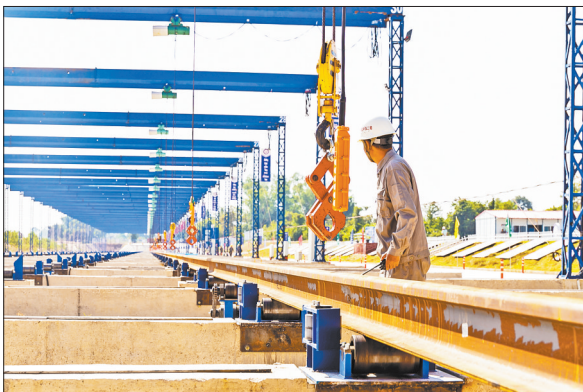
12月2日是老挝国庆节。当天,中老铁路首根500米钢轨在位于老挝首都万象的中铁二局焊轨基地完成焊接“出炉”,标志着中老铁路焊轨基地正式投入生产,为中老铁路全线轨道铺设奠定了坚实基础。 新华社发
