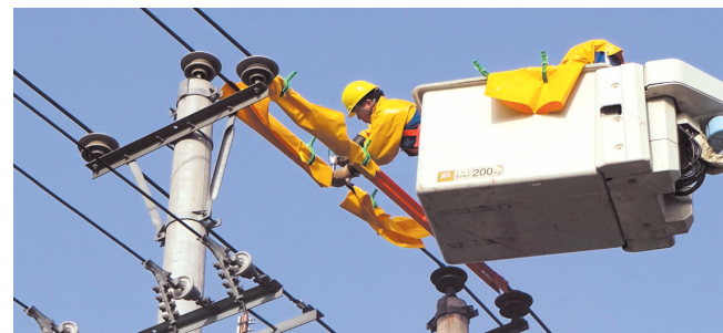
今年以来,隆尧县供电公司坚持以服务客户为中心,全力保障电力可靠供应。图为10月9日,该公司作业人员在县城10千伏051线路进行带电更换防污直屏。 董斌 摄
