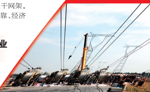
2015年，锡盟—山东1000千伏特高压交流输变电工程放线施工
