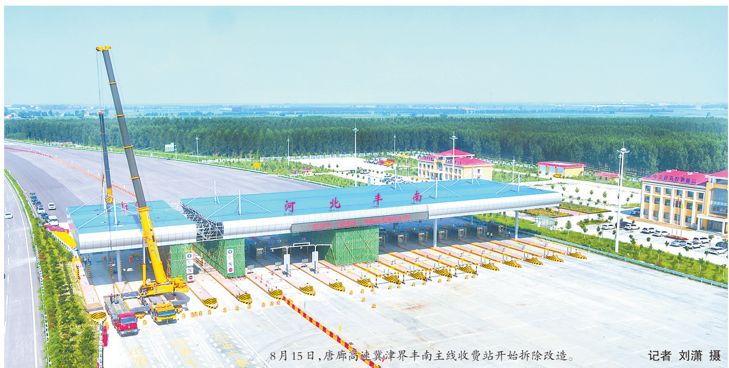
8月15日,唐廊高速冀津界丰南主线收费站开始拆除改造。 记者 刘潇 摄 费车道改造完成可正常通车后,对剩余的13条车道进行处理。根据计划,丰南主线收费站将于10月31日前完成主线大棚拆除、路面施工及交安设施施工,具备主线通车条件。 今年12月底前,我省将完成与交通运输部系统联调测试和高速公路入口不停车称重检测设施建设,具备取消高速公路省界收费站条件。按照交通运输部统一部署和时间安排,全国
