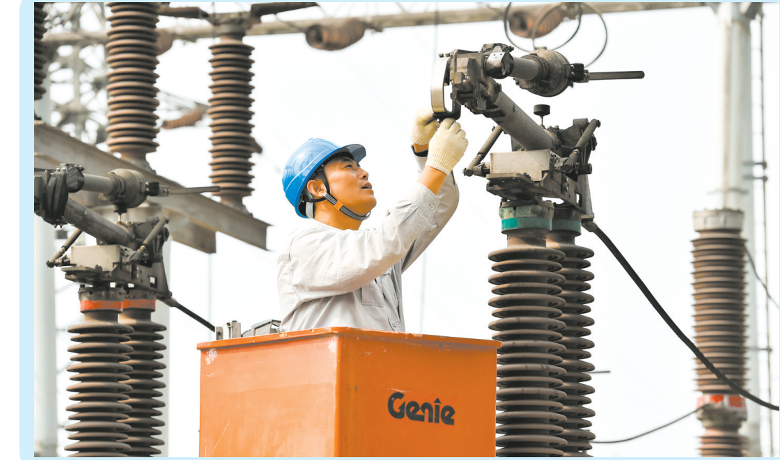
入伏以来,随着气温攀升,唐山电网负荷不断增加,电网设备在高温、高负荷的双重考验下易发生隐患。为确保用户正常用电,供电检修人员24小时待命,随时准备处理临时故障。图为8月6日唐山供电公司变电检修室工作人员正在对220千伏都庄变电站主变进行检修消缺。
