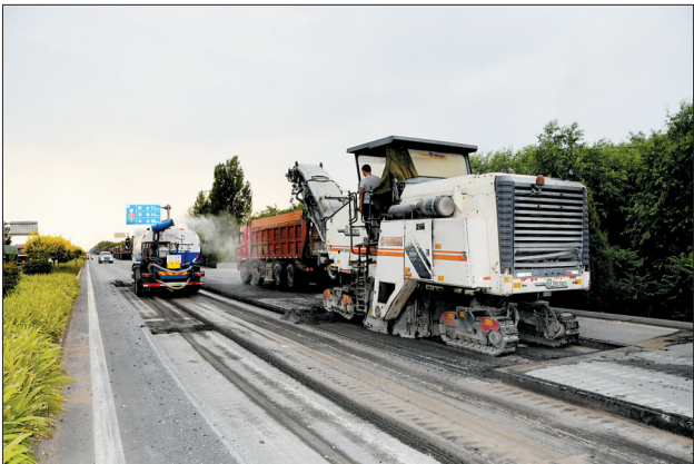
连日来,邯郸市交通运输局加快309国道小修保养和道路病害挖补工作,消除路面安全隐患,保障干线公路运营安全畅通。截至目前,已完成病害路面坑槽挖补2万余平方米。 商风谦 刘振国 摄
