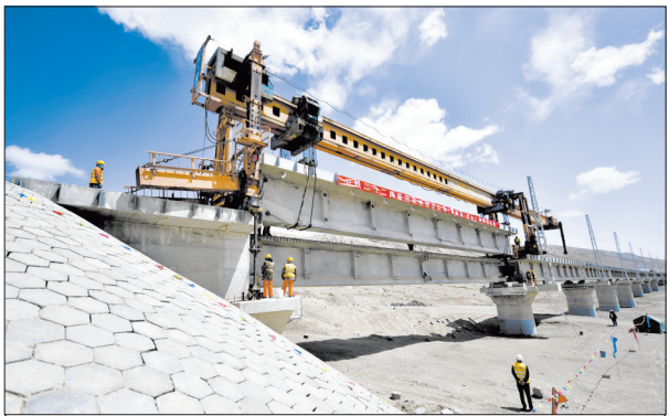
5 月 7 日，中铁二十二局集团施工人员在格库铁路茫崖湖 2 号特大桥上架设 T 梁。当日，青海格尔木至新疆库尔勒铁路青海段线下主体工程顺利完工。全长 1214 公里的格库铁路是国家重点项目，格库铁路青海段预计今年 6 月份完成铺轨，铁路全线预计 2020 年建成通车。 新华社记者 张龙 摄
