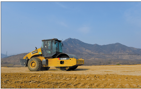
目前,南绕城高速公路项目建设已全面铺开,项目主线全长52.89公里,起于石太高速公路南良都互通西侧,顺接平赞高速,与青银高速石太段形成十字交叉。同时,该项目与石衡高速公路组合,将形成省会“东出西联”南部主要通道。图为山前大道互通匝道路基上压路机正在进行作业。马静 摄
