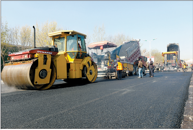
为进一步提升县城环境质量,全面提升县城形象,枣强县住建局抓住当前有利时机,对县城破损道路进行沥青罩面。截至目前已完成平原街、规划路沥青罩面5.1万多平方米,改善了市民出行环境。图为平原街沥青罩面施工现场。
