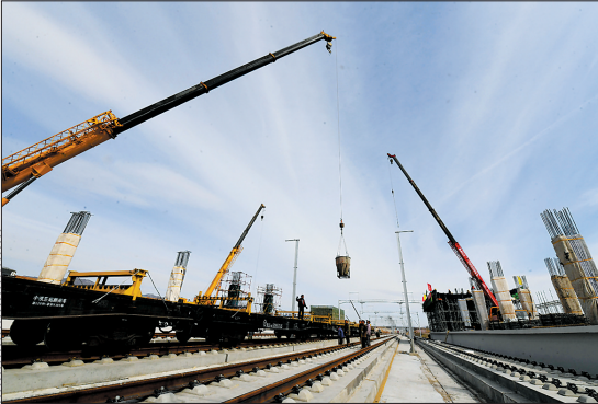
京张高铁怀来站位于京张线怀来县主城区东侧,站房总建筑面积1万平方米,旅客发送量近期(2020年)高峰小时510人,远期(2030)年高峰小时590人。图为该站正在紧张建设中。孙慧军 摄
