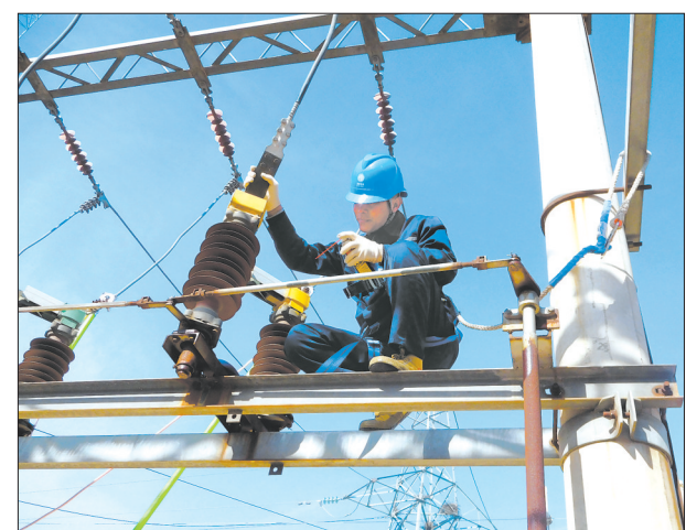
3月25日,国网东光县供电公司共产党员服务队队员在该县南霞口镇丁庄村检修灌溉设备。入春以后,国网东光县供电公司共产党员服务队队员积极配合各供电所,对乡镇农灌变压器进行重点巡视维护,确保春耕生产用电安全。 赵思梦 摄
