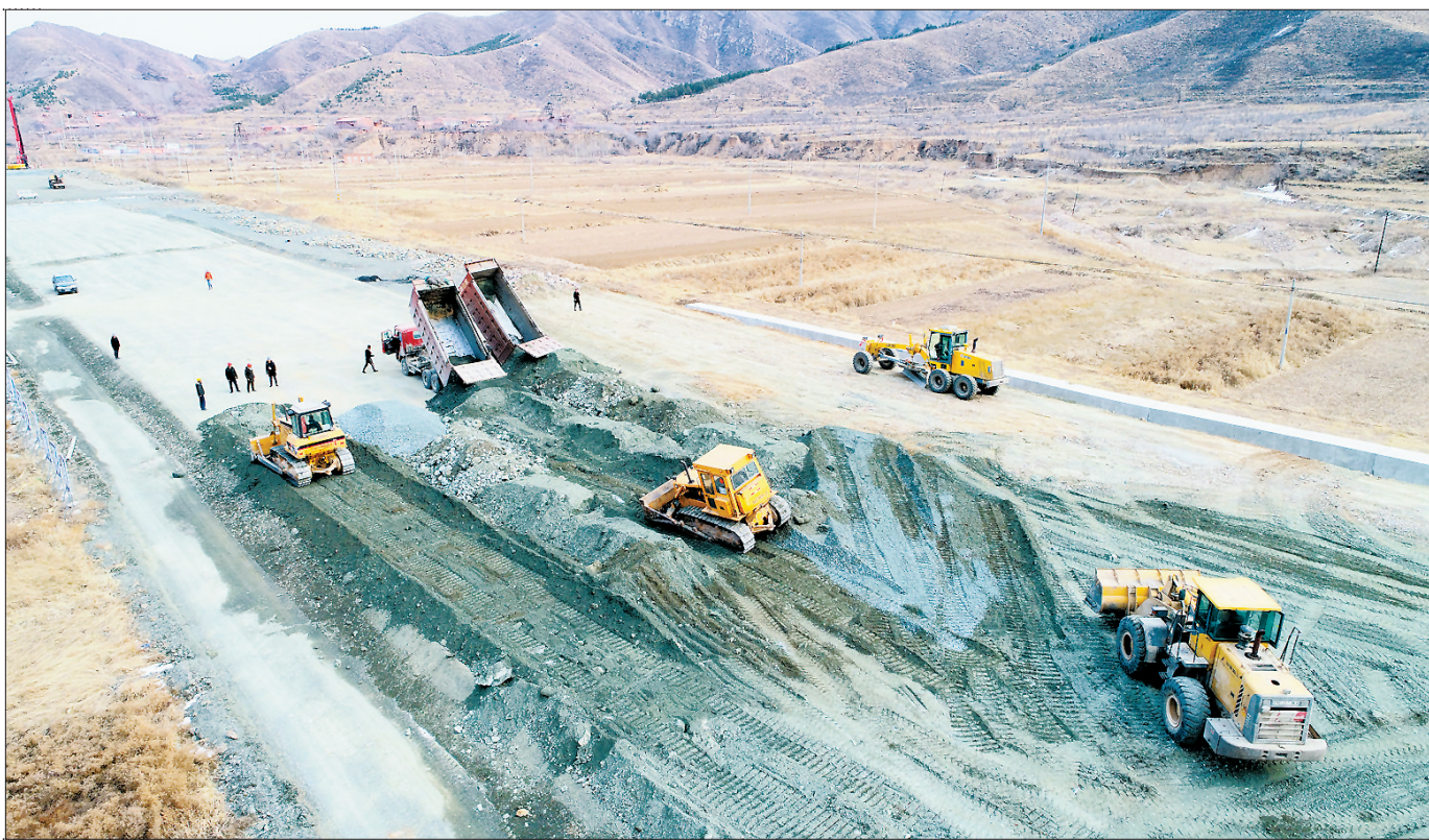
2019年是延崇高速公路河北段建设的关键年,决胜年,通车年。全线广大建设者早谋划、早准备、早进场、早开工,科学组织、倒排工期、挂图作战、定时推进、跟踪监理,合理调配人员与设备,为2019年底全线建成通车奠定坚实的基础。图为2月25日延崇高速公路河北段第七合同项目部正在进行路基填筑施工。 李英军 李建冲 摄
