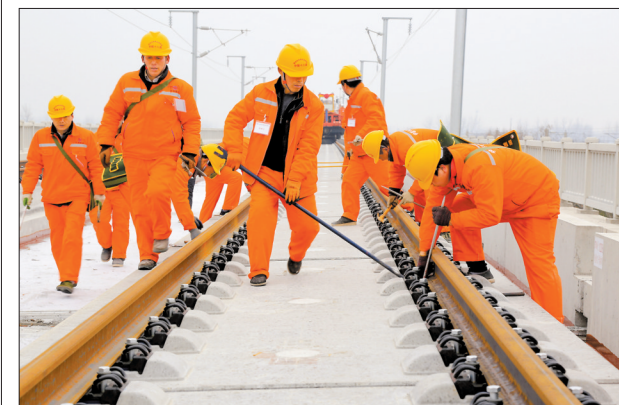
2月26日上午9点,随着一对500米长钢轨在安徽省亳州市的古城东站顺利铺设,标志着我国华东地区第二条快速客运通道——商(丘)合(肥)杭(州)高铁正式开始铺轨。商合杭高铁全长约795公里,工程总投资约960.8亿元,设计行车时速350公里,线路北接徐济高铁,并与北京至福州高铁和沪汉蓉高铁相连,是纵贯安徽省全境、连接中原、江淮与长三角地区的重要交通主干线。新华社发
