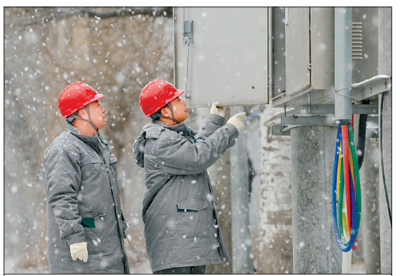
近日,三河市出现降雪天气。国网三河市供电公司迅速组织员工奔赴辖区重点部位,开展电力线路巡视工作,确保电网安全稳定运行。图为该公司员工冒雪巡视电力线路。 邹明 摄
