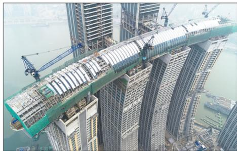
这是1月14日拍摄的重庆来福士广场“空中连廊”幕墙工程施工现场(无人机拍摄)。当日,重庆来福士广场“空中连廊”幕墙工程顺利合拢。位于重庆市渝中区朝天门码头的重庆来福士项目建筑由八栋修长塔楼、商业裙楼和一座约300米长的“空中连廊”组成。 新华社记者 王全超 摄
