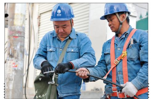
11月2日,国网宁晋县供电公司大曹庄供电所台区经理刘志兴和王丁钦正在处理泊里庄村内02号变压器的C相接头隐患。确保设备安全运行水平,全力保障老百姓安全可靠用电。杨建鹏 陈士钊 摄
