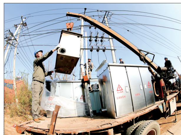
11月16日,国网东光县供电公司电力员工在该县于桥乡小刘村进行变压器更换施工。该公司贫困村电网改造工程在电。该公司贫困村电网改造工程涉及10KV项目10个、0.4KV项目17个;建设线路27.35千米,新增配变23台,动态总投资422.33万元。全部完工后,将为贫困村提供安全稳定的电力保障。 记者 任阳光 摄
