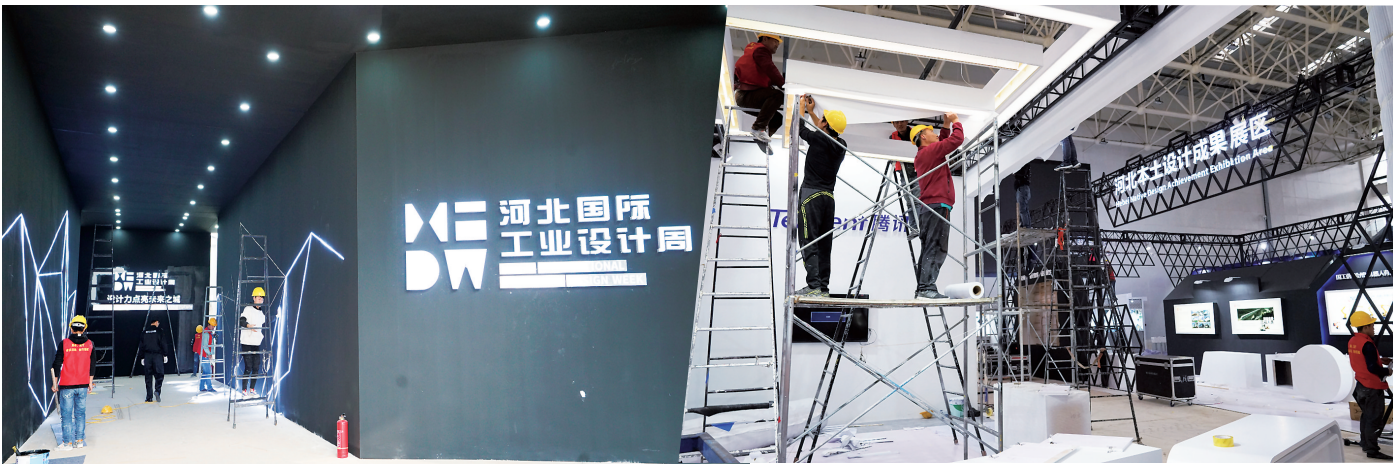
河北本土设计成果展区施工现场。
