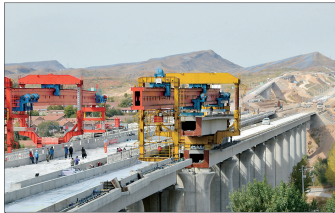
10月8日,经过230名建设者436天日夜艰苦奋战,由中铁二十局承建的北京2022冬奥重点配套工程——京张高铁崇礼支线架梁施工圆满完成。 曲志忠 摄
