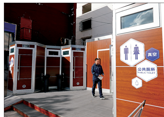
日前,张家口桥东区采取真空技术在6个点试点全新公厕建设工作,该技术配有真空泵,利用真空负压原理将粪便、尿液导入收集池,节省水源、无臭无味。 朱国君 岑屹 武殿森 摄
