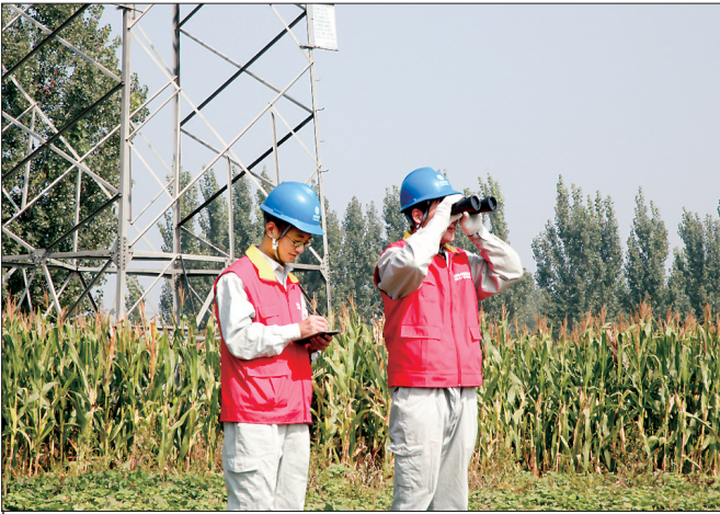
近日,霸州供电公司启动了全面维护设施线路机制,开展细致检修大排查,确保输电线路安全稳定运行。图为该公司廊桥共产党员服务队队员来到开发区对110千伏线路康许线开展特殊巡视,确保用电安全。赵亚彬 摄
