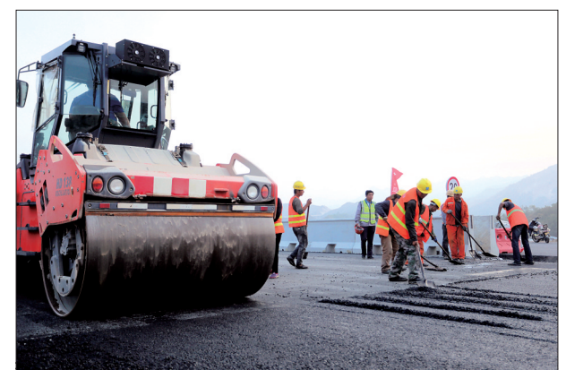
10月5日,在大太行山高速公路西阜(西柏坡至阜平)保定段东坊子大桥工程现场,施工人员进行沥青路面摊铺作业。该段由中建路桥集团有限公司承建,路线全长23.963公里,全线采用双向四车道高速公路标准建设。截至目前,西阜保定段全线双幅路基全部完工,桥梁工程已完成99%,隧道完成98%。国庆期间,中建路桥集团有限公司2000余名施工人员在建设一线,为高质量按期完成大太行山高速公路项目贡献力量。记者 任阳光 通讯员 樊连贵 摄
