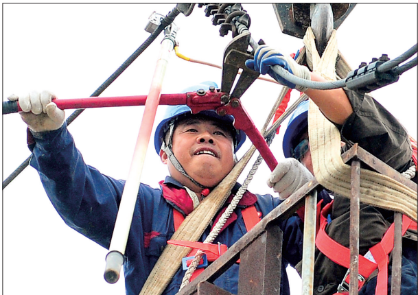
近日,国网阜城县供电公司员工在检修变压器设备。该公司加大对电网设备的检修维护力度,精准化安排、精细化管控,及时消除各类安全隐患,确保检修无遗漏、无隐患、无缺陷,保障电网设备安全可靠运行。
